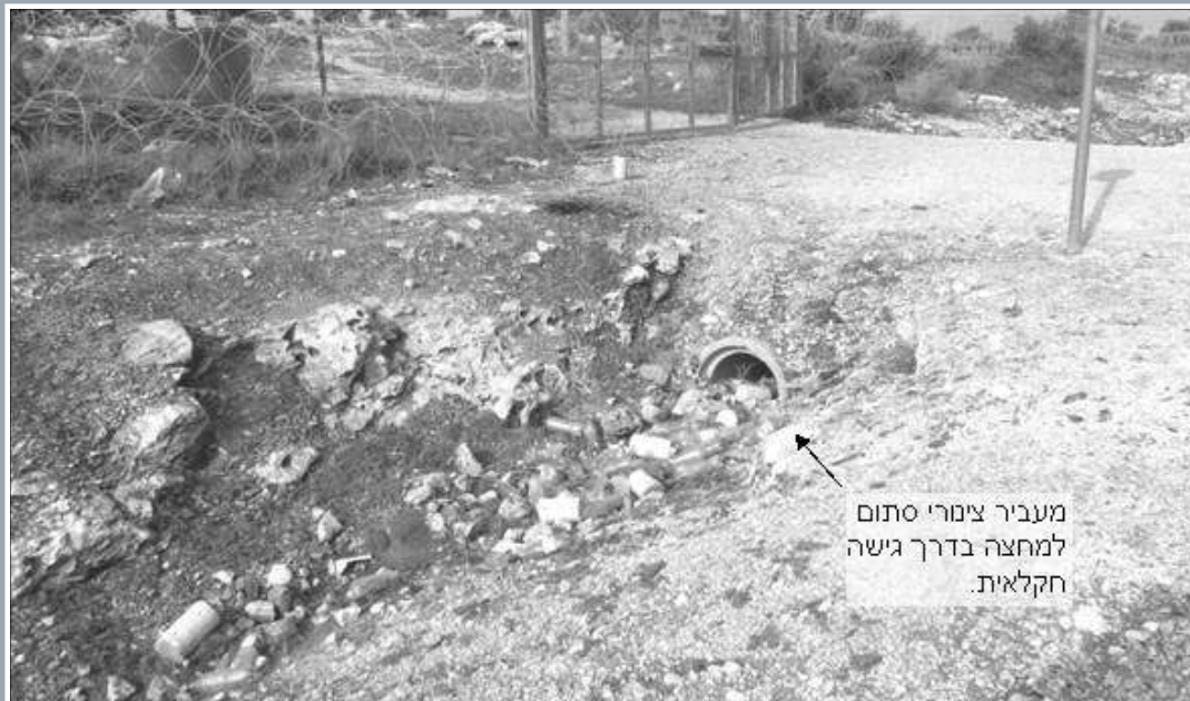
תרשים ג-26 מעביר מים לאורך תעלת הניקוז המשמש לצורך גישה חקלאית
