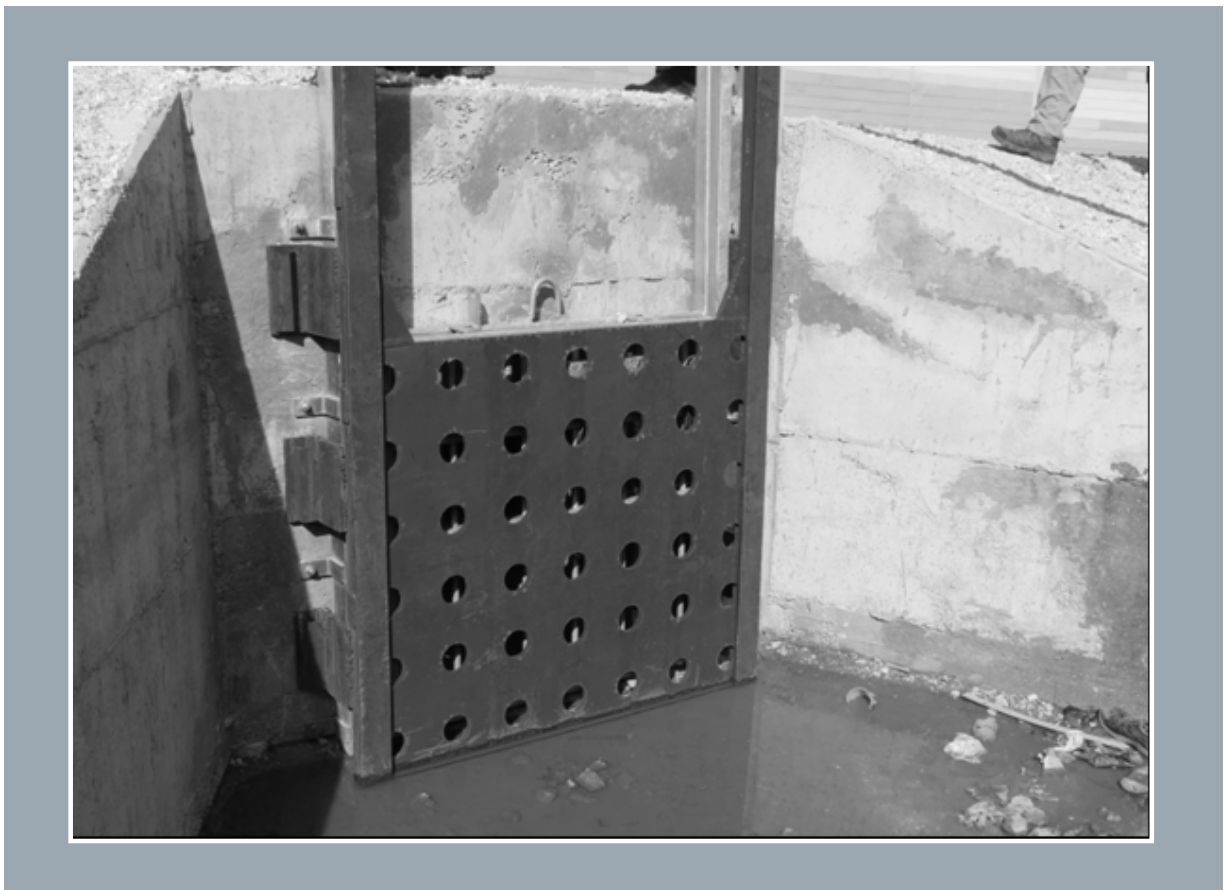
תרשים ג-32 תוספת פלטת ברזל מחוררת לסבכה בצדו המערבי של מעביר מים
