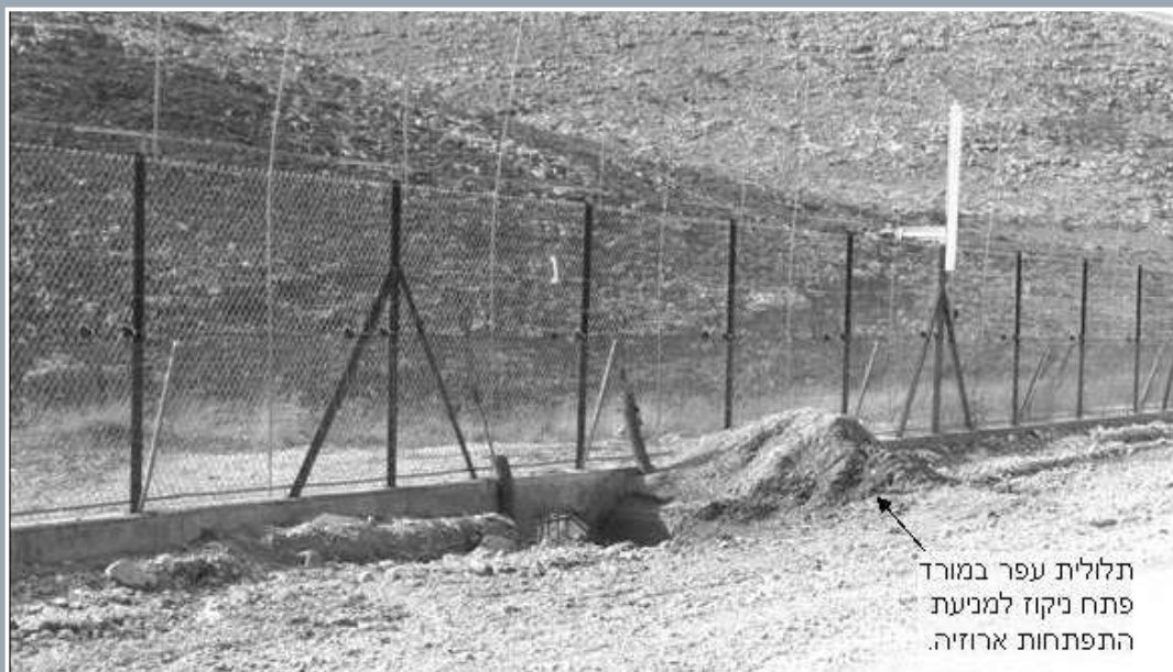
תרשים ג-25 דרך הטשטוש עם מתקן ניקוז המצויד בתלולית למניעת ארוזיה
