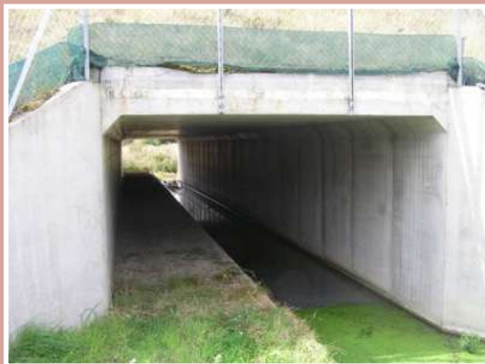
תרשים ה-6 מימין: מעביר מים בנחל מודיעים שאינו מותאם למעבר בעלי חיים, משמאל: מעבר תחתי לבעלי חיים עם מדרגה יבשה ופתח רחב בצרפת (צילום ז'מ. דופורדרור)
