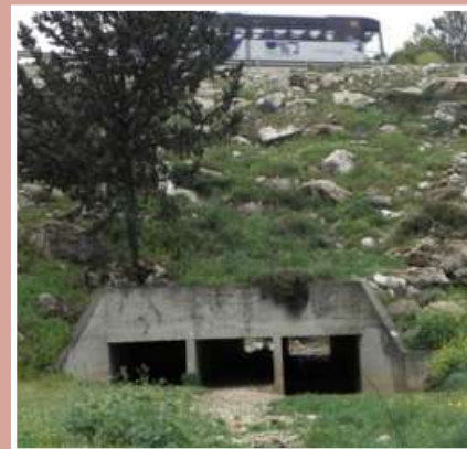
תרשים ה-6 מימין: מעביר מים בנחל מודיעים שאינו מותאם למעבר בעלי חיים, משמאל: מעבר תחתי לבעלי חיים עם מדרגה יבשה ופתח רחב בצרפת (צילום ז'מ. דופורדרור)
