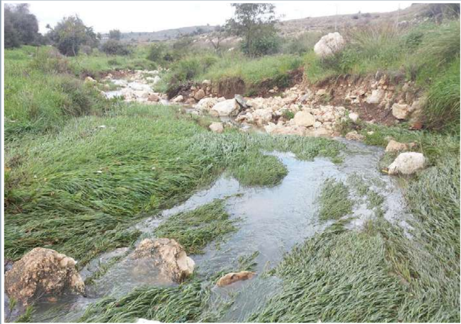
תרשים ג-48 התמוטטות גדות 20 מטר במורד הכניסה של הנקז העירוני המוצג בתרשים הקודם
