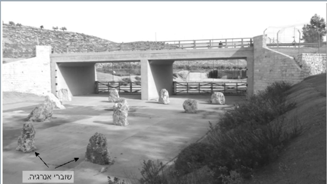
תרשים ג-29 חציית ואדי נטוף באמצעות גשר עילי (מבט ממערב)
