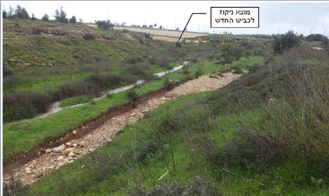
תרשים ג-49 התפתחות ערוץ מקביל כתוצאה ממוצא ניקוז של כביש חדש המוביל לפארק הטכנולוגי
