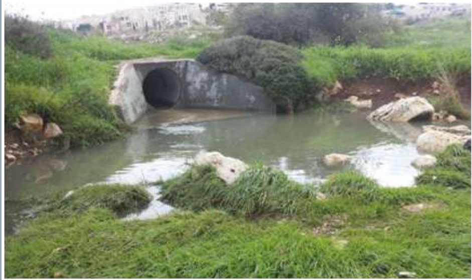
תרשים ג-47 כניסה של נקז עירוני במעלה היובל המרכזי-צפוני (סדר 1) של נחל ענבה
