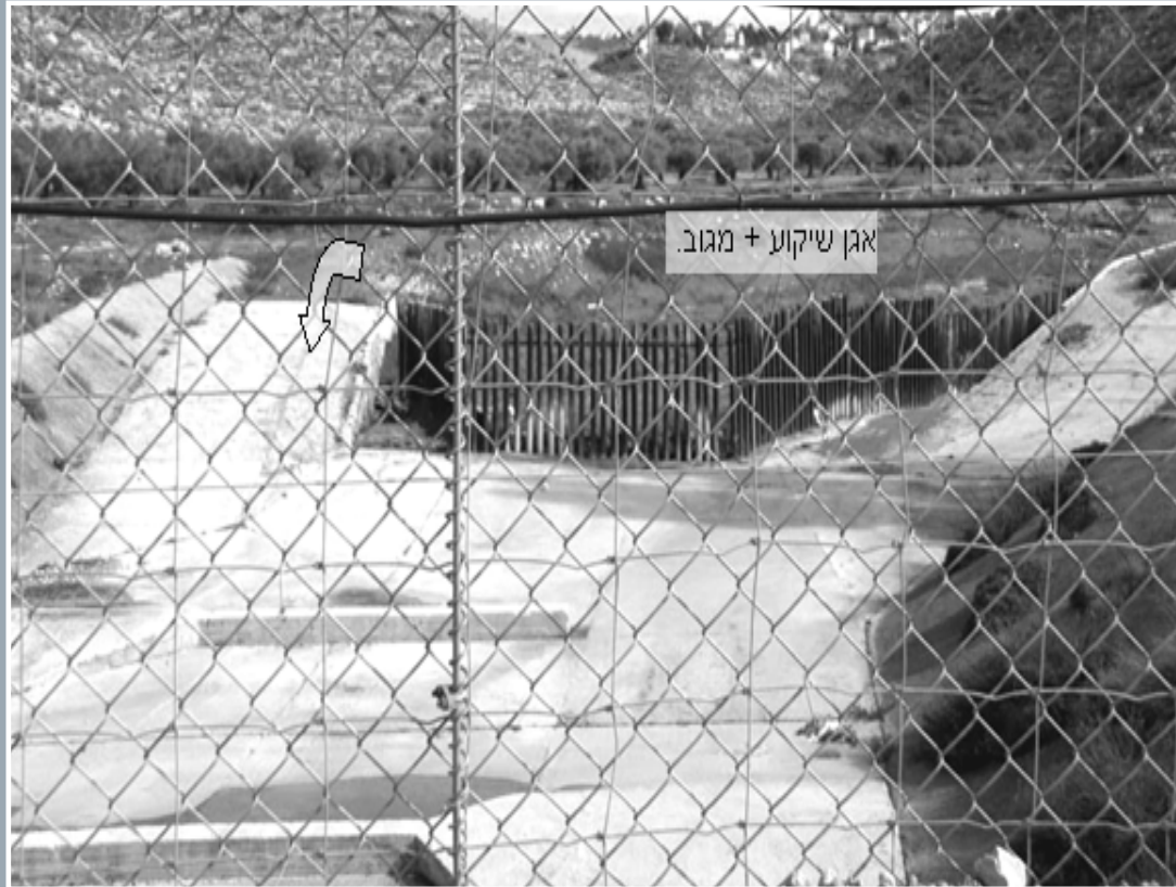
תרשים ג-30 אגן שיקוע ומגוב לגרופת במעלה גשר ואדי נטוף (משמאל נתיב גלישת עודפים)
