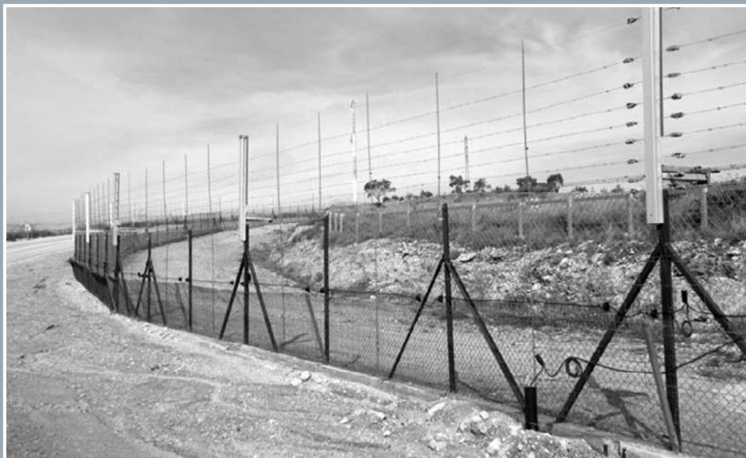
תרשים ג-23 דוגמה לגדר 'חכמה' ושביל הטשטוש שלצידה
