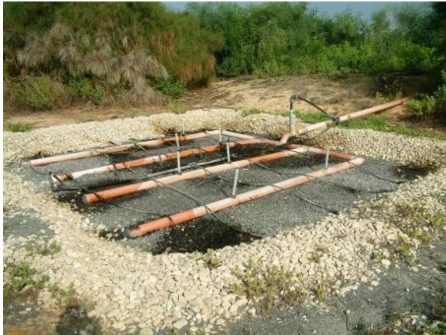
איור 4: בריכה 1-3 המוזנת בדפוס זרימה תת-קרקעי אנכי (vertical subsurface flow) ללא צומח. רשת צינורות שחורים מיועדים לפיזור קולחים בספיקות נמוכות. זקיפים אפורים על פני הצנרת הכתומה משמשים לפיזור והצפה של הקולחים בספיקות גבוהות.
