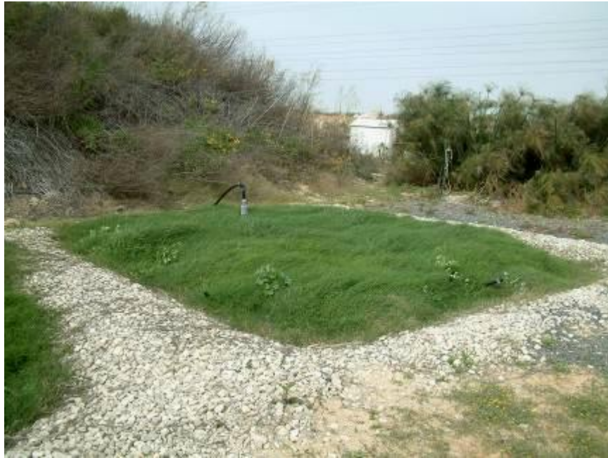
איור 5: בריכה 1-6 המוזנת בדפוס זרימה תת-קרקעי אנכי (vertical subsurface flow) ובה צמחיה עשבונית (יבלית)
